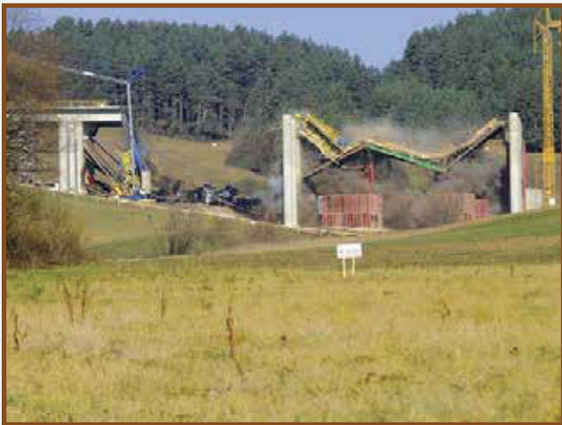
Meranie účinkov odstreľu poškodeného mostného objektu na diaľnici D1 Blasting effects measuring of damage bridge on the D1 highway
