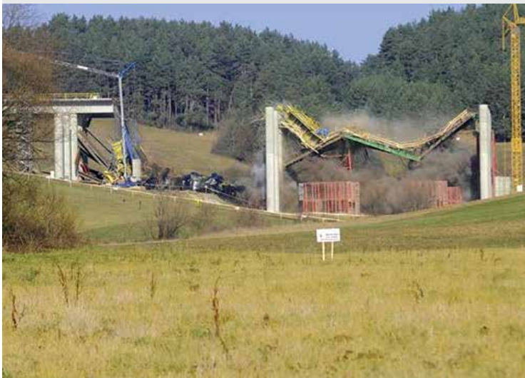
Meranie účinkov odstrelu poškodeného mostného objektu na diaľnici D1 / Blasting effects measuring of damage bridge on the D1 highway
